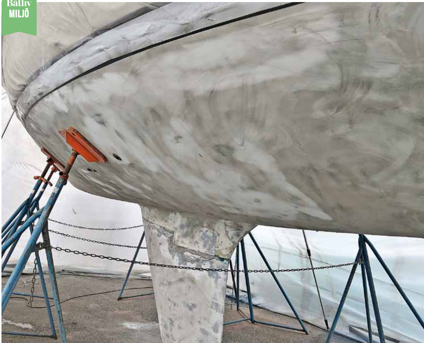
Lätt att nå hela båtbottnen med blästringstrutningen. Skrovet är blåstrat upp till vattenlinjen.
